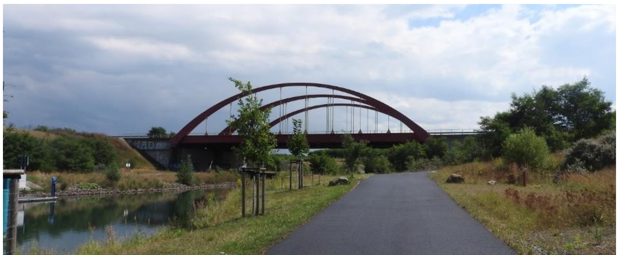
Beispiel A38-Brücke nahe Kanupark-Schleuse [3] Spannweite 60 m
