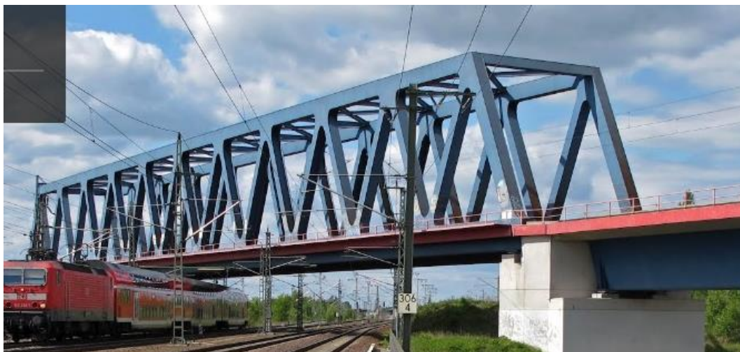
Beispiel Eisenbahnbrücke neben B2, Wiederitzsch [3] Spannweite 120 m
