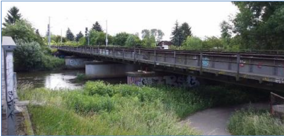
EÜ Weiße Elster [2] Unterkante der neuen Brücke wird noch niedriger: -0,75 m (Fluss) bzw. -0,50 m (Vorland)
